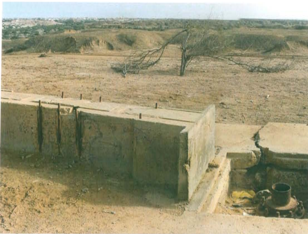
Fotografía N° 2. Vista panorámica del del área circundante del pozo inactivo T2568 en el que se visualiza la viga monolítica (base de la unidad de bombeo).
