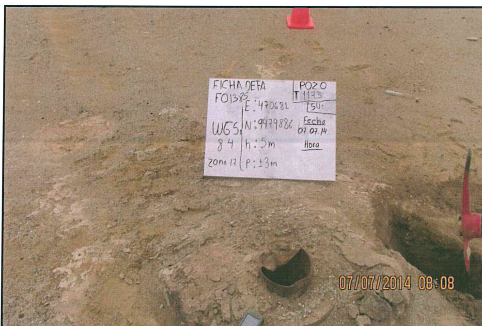
Fotografía N° 2. Pozo con código PERUPETRO T1173; con casing cortado a una altura de 0,2 m desde la superficie del suelo.
