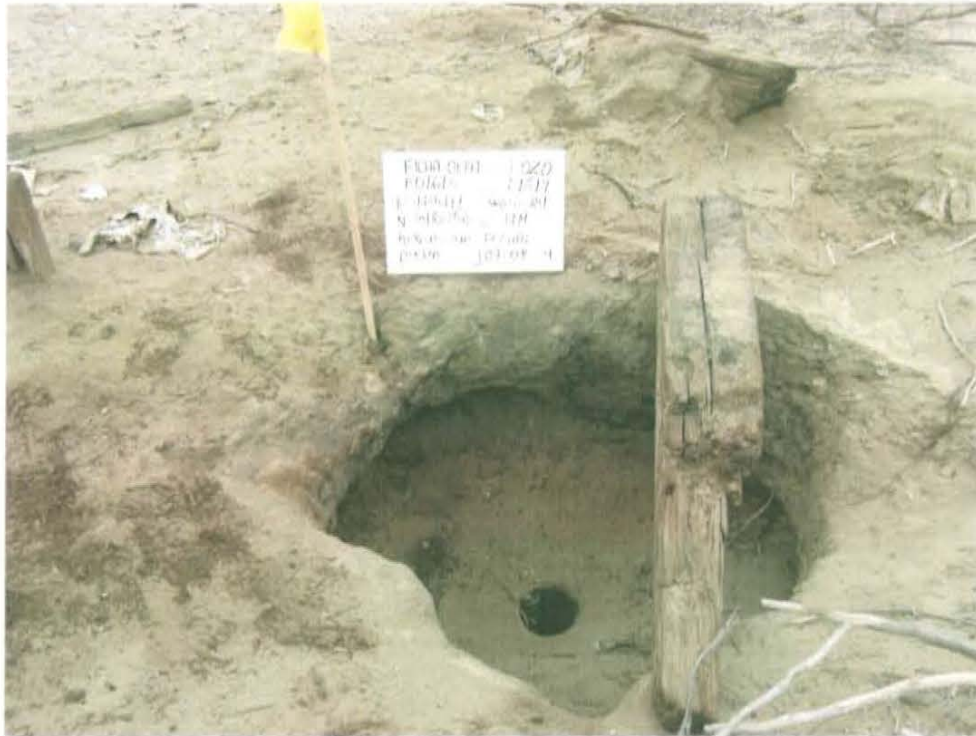
Fotografía N° 1. El Pozo T1819, se ubica en un hoyo, en donde se observa el casing cortado al ras del suelo con un diámetro de 8 pulgadas y un tubing de 2,5 pulgadas, sin cabezal ni válvulas que aseguren su hermetismo.
