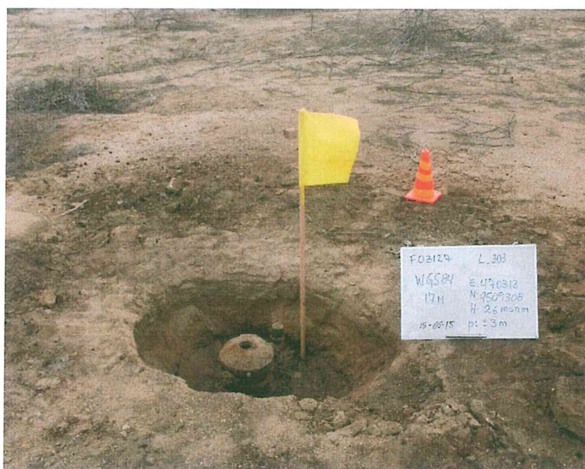
Fotografía N° 2. Pozo L_303, presenta un cabezal compuesto por una brida con un orificio concéntrico de 2,5 pulgadas, lateralmente hay una tubería con el interior cubierto de arena, no se evidencian válvulas que aseguren su hermetismo.
