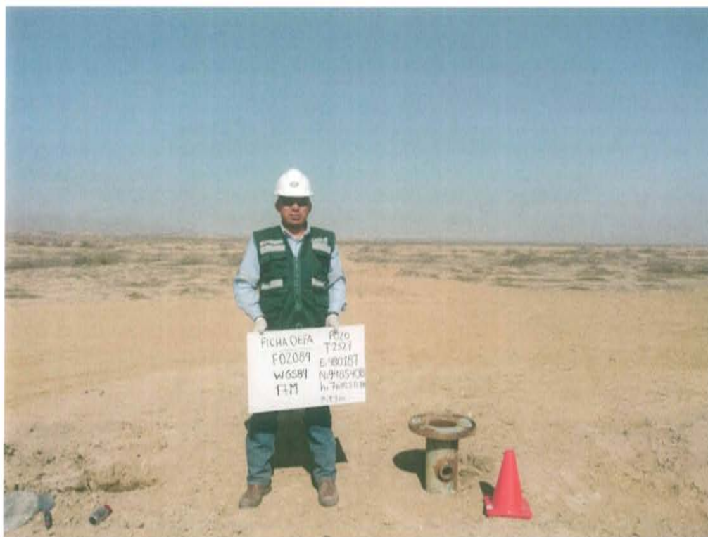
Fotografía N° 1. Identificación del pozo inactivo con código PERUPETRO T2527. Presenta casing con tapa de brida adaptadora con salidas laterales y expuestas a la intemperie.
