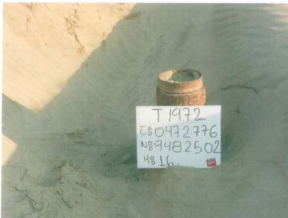
Fotografía N° 1. Pozo inactivo mal abandonado de la Ficha OEFA F00419, presenta casing sin cabezal y cubierto con arena en su interior.
