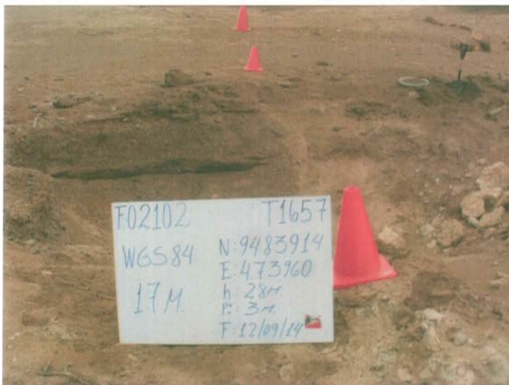
Fotografía N° 1. Pozo T1657 sin cerco ni señalización
