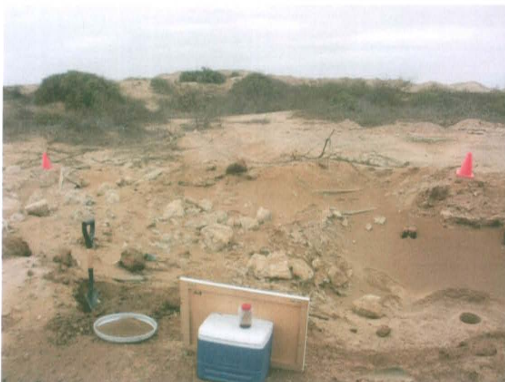
Fotografía N° 2. Pozo T1657 ubicado dentro de una cantina deteriorada y erosionada Sin cabezal, se aprecia la tubería de producción a nivel de la base de la cantina.
