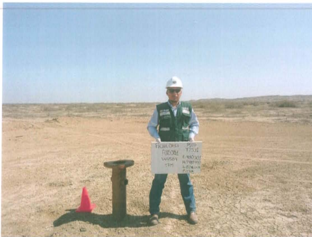
Fotografía N° 1. Identificación del pozo inactivo con código PERUPETRO T2531. Presenta casing con tapa de brida adaptadora y con salidas laterales, expuesta a la intemperie.
