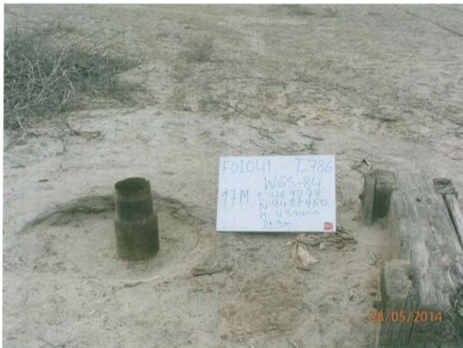
Fotografía N° 2. Coordenadas de ubicación del pozo T_786, abierto al ambiente sin accesorios que aseguren su hermeticidad.
