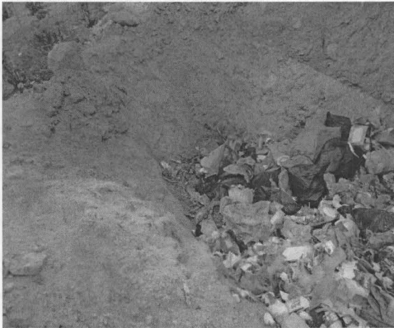
Fotos 9 - 10: Evidencias de la operatividad de la única trinchera de 4 m 2 por 3 m de profundidad a cielo abierto, en el botadero de Marcocancha
