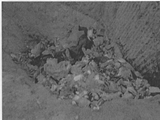
Foto 11: Operatividad de la única trinchera de 4 m 2 por 3 m de profundidad
