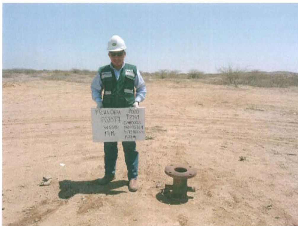
Fotografía N° 1. Identificación del pozo inactivo con código PERUPETRO T2361. Presenta casing corroído con tapa de brida adaptadora y tuberías laterales, expuestas a la intemperie.
