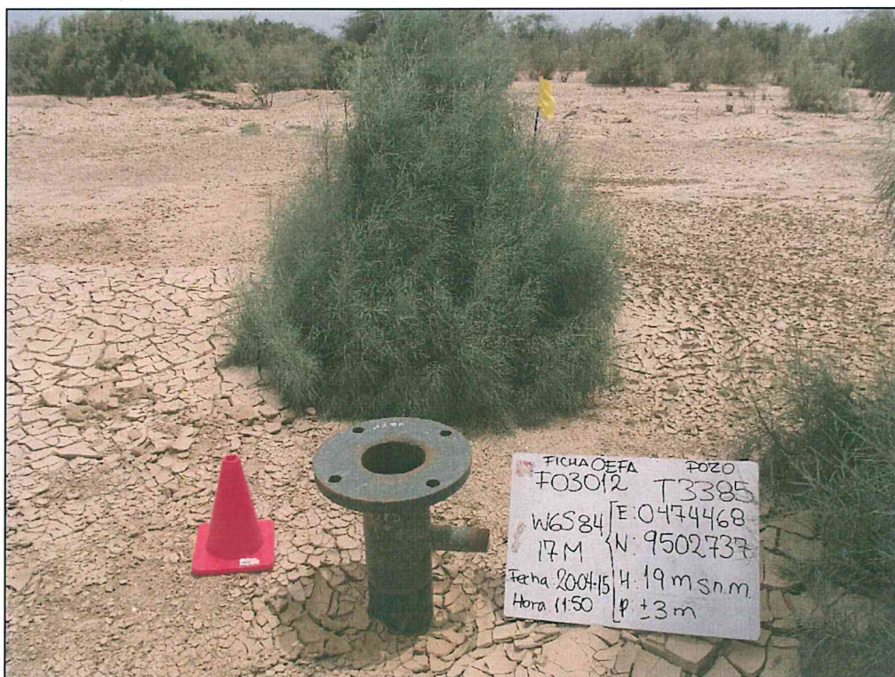
Fotografía N° 1. Ubicación del pozo inactivo T3385, con casing corroído de 10 plgs de diámetro y de 0,6 m de altura sobre el nivel del suelo, sin cabezal y unido a la mitad inferior de una brida.
