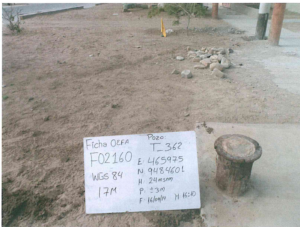
Fotografía N° 1. Se observa casing corroído.
