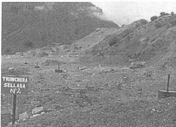
Fotografías N° 12a y 12b. Vista panorámica de la trinchera N° 2, debidamente sellada, con sus respectivas chimeneas y quemadores de biogás, en el Botadero de Jahuacollay, del Distrito de Urubamba, en el punto georeferenciado N° 3, del Cuadro N° 1. Coordenadas UTM WGS 84 (18L 813670E 8525146N)
