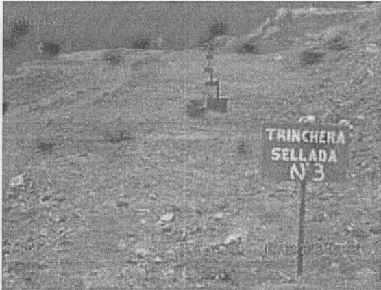
Fotografías N° 13a y 13b. Vista panorámica de la trinchera N° 2, debidamente sellada, con sus respectivas chimeneas y quemadores de biogás, en el Botadero de Jahuacollay, del Distrito de Urubamba, en el punto georeferenciado N° 4, del Cuadro N° 1. Coordenadas UTM WGS 84 (18L 813656E 8525162N)
