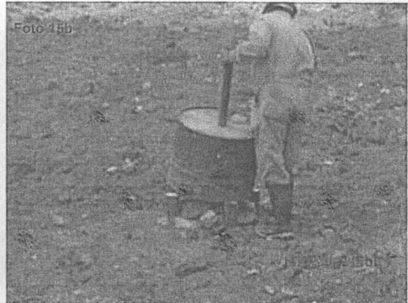
Fotografías N° 15a y 15b. Evidencias del tipo de soterrado y colocación de chimeneas con quemadores de biogás en la trinchera N° 4, próximo a ser sellada, en el Botadero de Jahuacollay, del Distrito de Urubamba, en el punto georeferenciado N° 5, del Cuadro N° 1. Coordenadas UTM WGS 84 (18L 813636E 8525196N)
