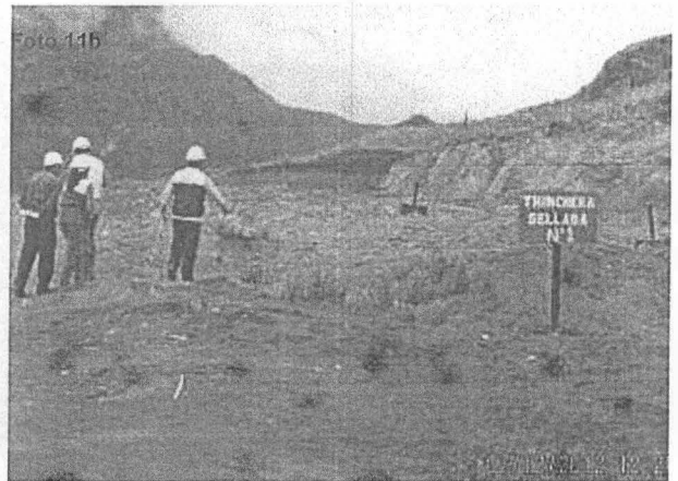
Fotografías N° 11a y 11b. Vista panorámica de la trinchera N° 1, debidamente sellada, con sus respectivas chimeneas y quemadores de biogás, en el Botadero de Jahuacollay, del Distrito de Urubamba, en el punto georeferenciado N° 2, del Cuadro N° 1. Coordenadas UTM WGS 84 (18L 813689E 8525116N)
