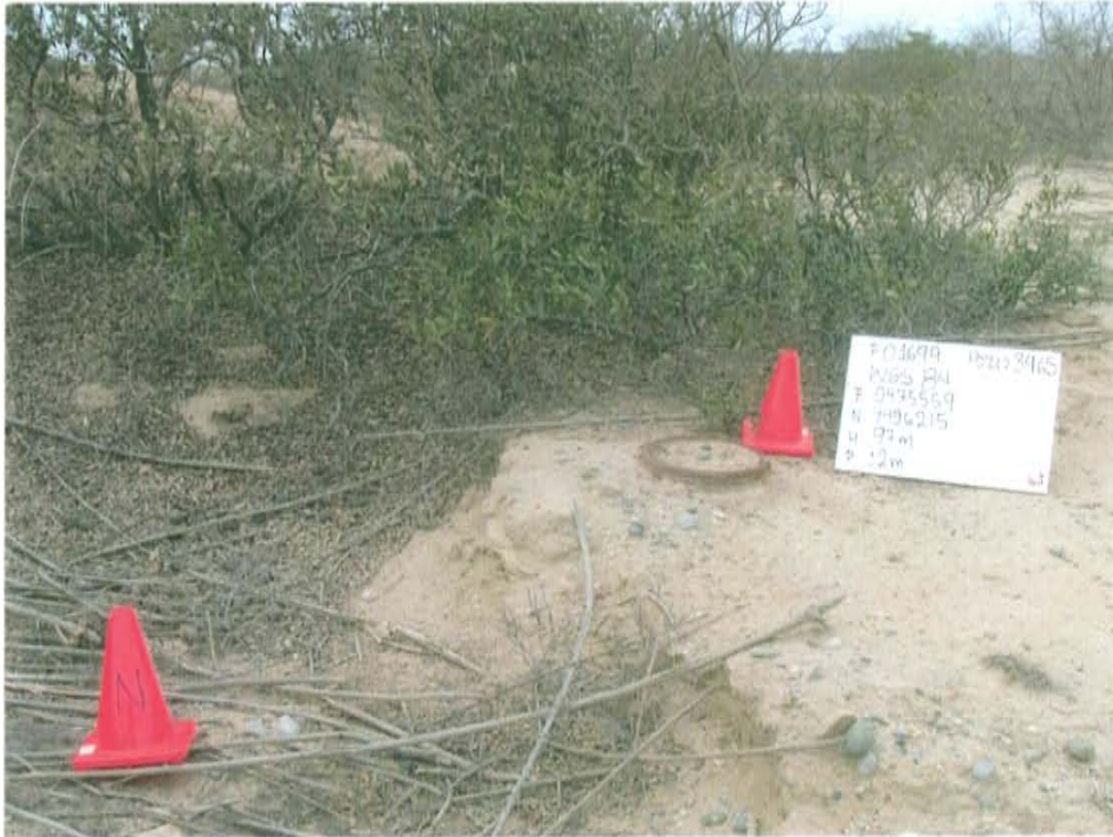
Fotografía N° 1. Identificación del pozo inactivo con código PERUPETRO T3465. Presenta casing sin válvulas que aseguren su hermetismo.
