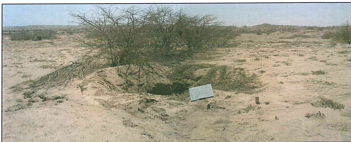
Fotografía N° 2. Vista de los alrededores del pozo. Se observa el terraplén inhabilitado, con signos de erosión y escorrentía superficial.
