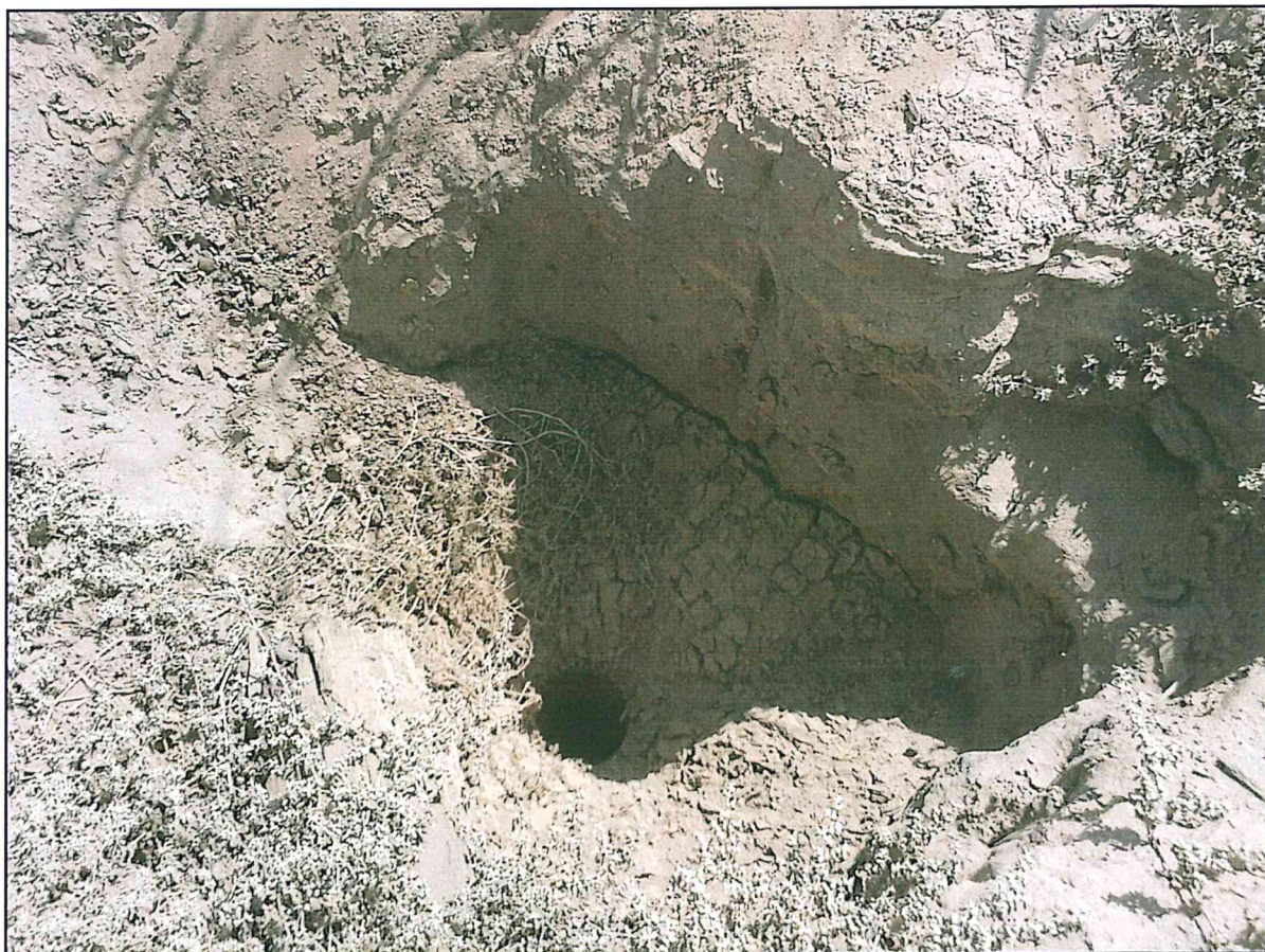
Fotografía N° 1. Se ubicó el pozo en una pequeña excavación, en donde se observa el casing cortado, sin ningún elemento de cierre que asegure su hermetismo.
