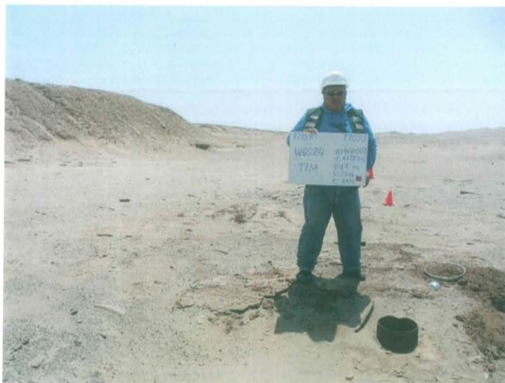
Fotografía N° 1. Se observa casing corroído que sobresale 0,15 m del nivel de la superficie del suelo y se encuentra abierto al ambiente.
