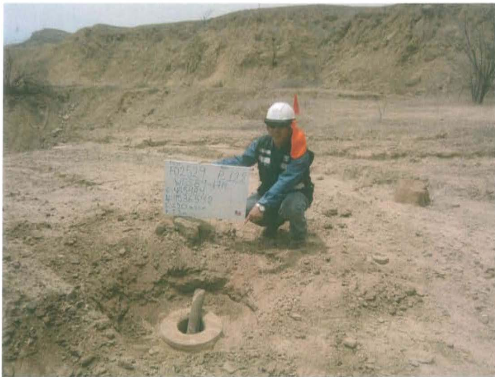
Fotografía N° 1. Identificación del pozo inactivo con código PERUPETRO P_122. Presenta dos casing concéntricos, uno de ellos cementado en la sección anular y el otro abierto, con una tubería de menor diámetro que sobresale en forma diagonal.
