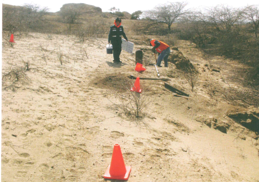
Fotografía N° 2. Alrededor del pozo se empezaron a realizar Excavaciones para ubicar suelos impregnados
