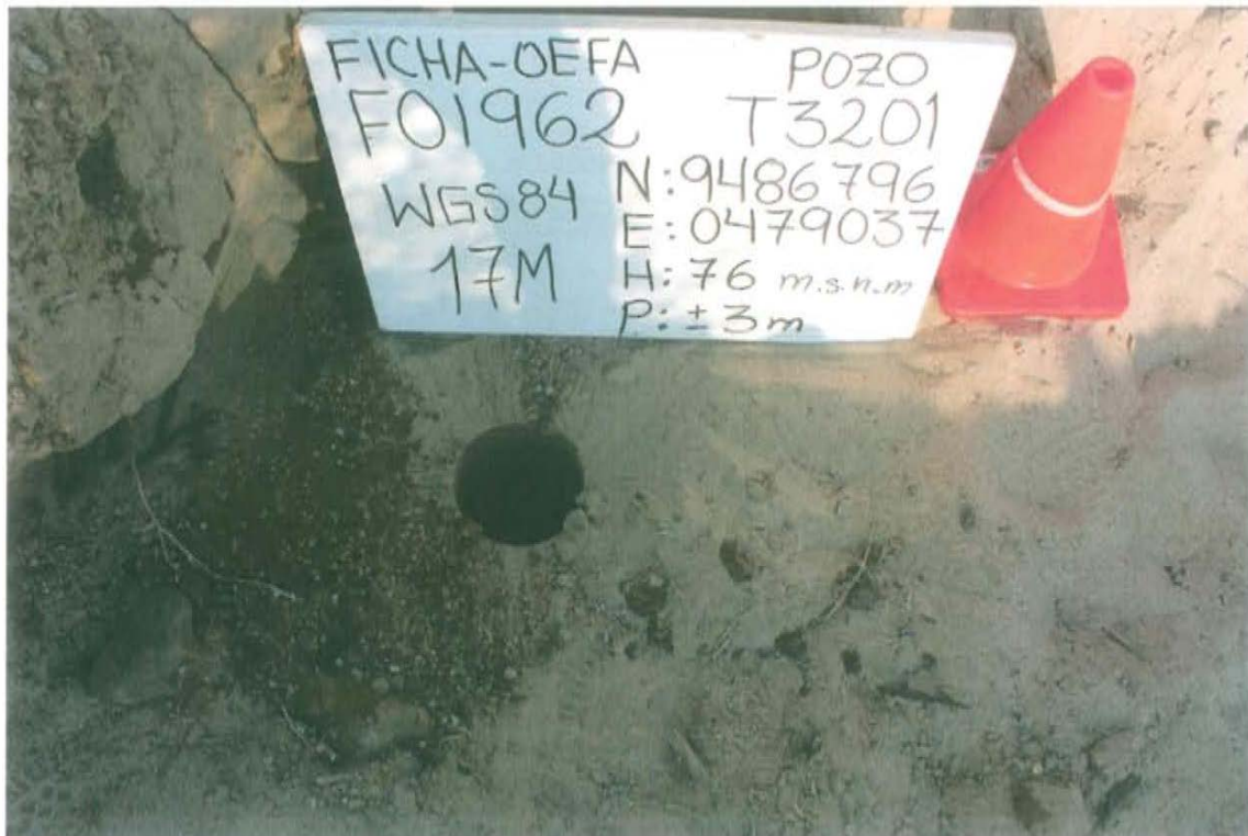
Fotografía N° 1. Pozo inactivo con código PERUPETRO T3201 el cual se encontró al nivel de la superficie del suelo.
