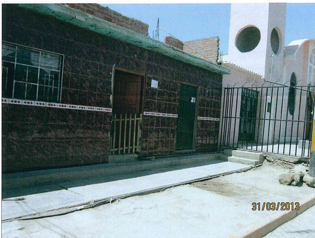
Fotografía N° 2. Conexiones clandestinas mediante tuberías para obtener gas del pozo T_154.
