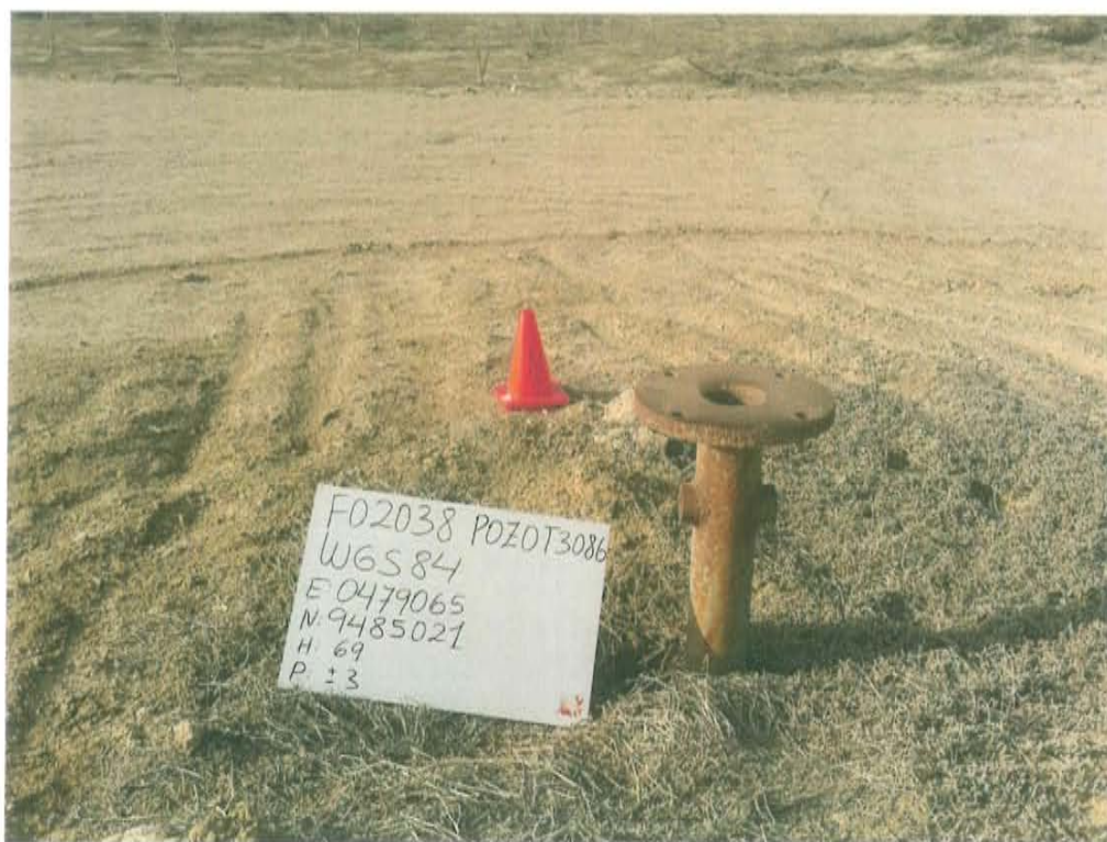
Fotografía N° 1. Pozo inactivo con código PERUPETRO T3086 donde se observa el casing con brida sobresaliendo una altura aproximada de 0,67 m sobre la superficie del suelo.
