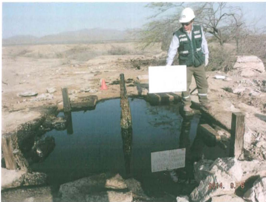
Fotografía N° 1. Pozo inactivo en terreno no habilitado dentro de cantina deteriorada de 3 m por 4 m de lado y de aproximadamente 0,5 m de profundidad el cual se encuentra lleno de agua mezclada con hidrocarburos.
