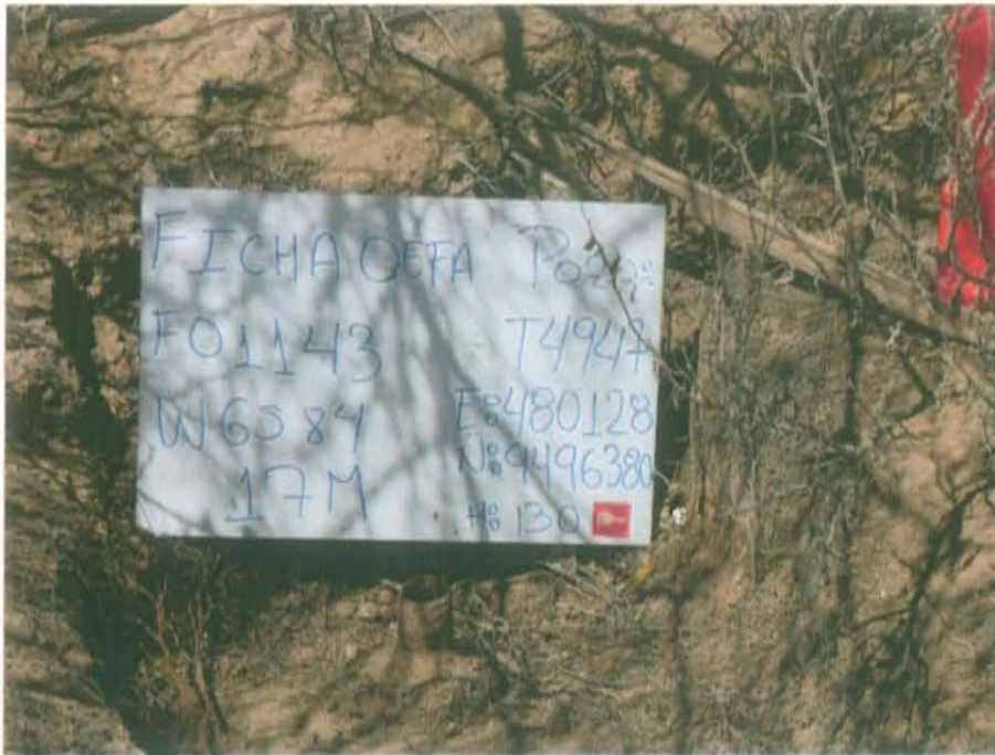
Fotografía N° 1. Pozo inactivo con código PERUPETRO T4947, se observa tubo de 2 pulgadas reducción enterrado, dentro de hoyo, no se observa afloramiento ni se percibe emisiones provenientes del pozo.
