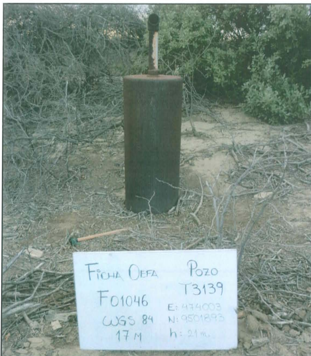
Fotografía N° 1. Pozo que cuenta con tapa soldada y tubo de salida de 2 plg en la parte superior, que emerge a una altura de 1,4 m desde la superficie del suelo.
