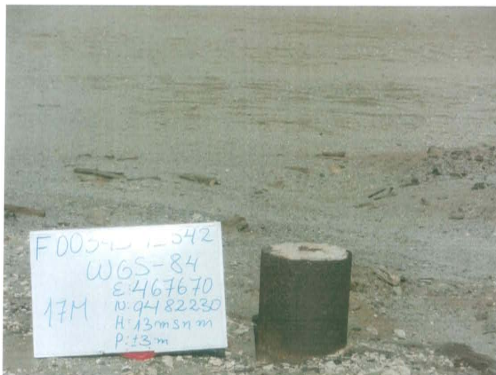
Fotografía N° 2. Vista del casing del pozo T_542, se observa el casing corroído y cementado a nivel superficial.
