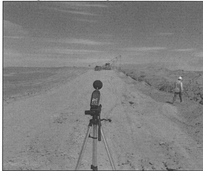
Fotografía N° 01. Pctg N 01 - CONTUGAS
