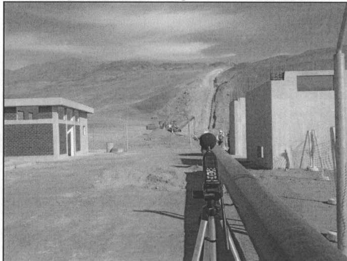
Fotografía N° 03. Pctg N 03 - CONTUGAS
