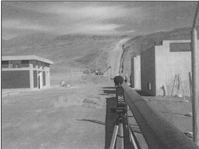
Fotografía N° 03. Pctg N 03 - CONTUGAS
