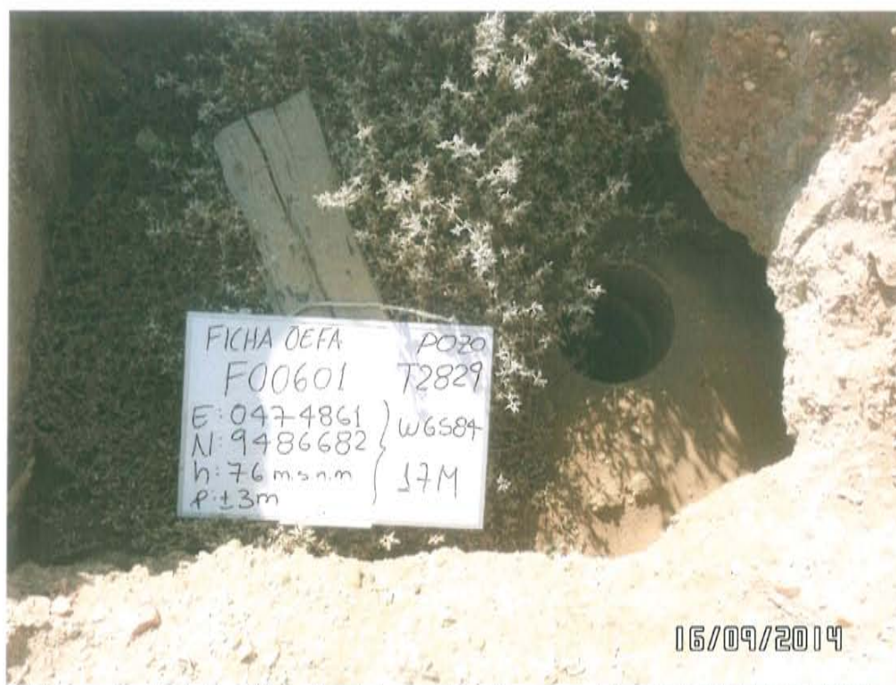
Fotografía N° 1. Identificación del pozo inactivo con código PERUPETRO T2829. Presenta casing descubierto en el interior de una excavación, con presencia de vegetación y expuesta a la intemperie.
