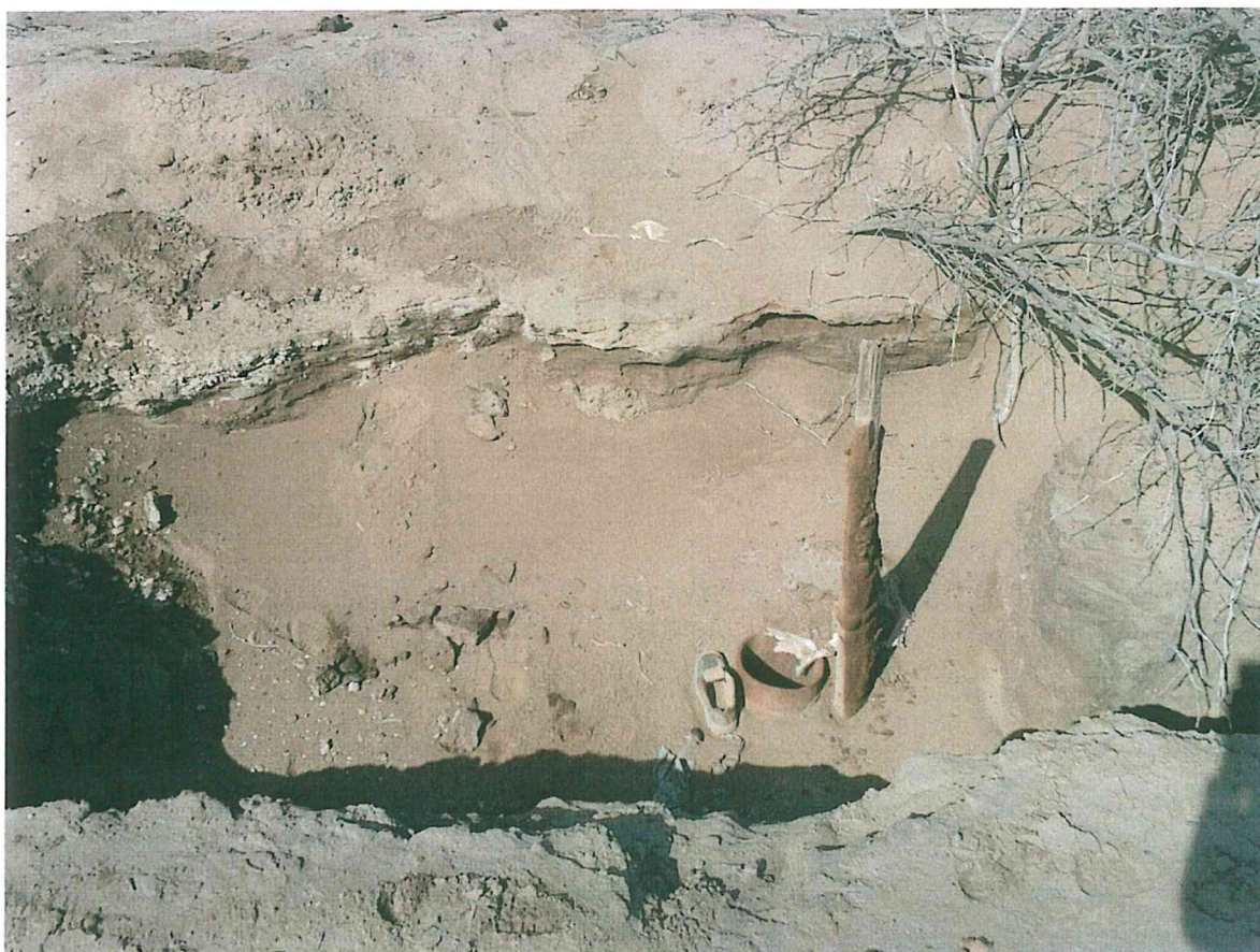
Fotografía N° 1. Vista del pozo con código PERUPETRO T1599 y con código Ficha OEFA F00530, se encuentra en el fondo dentro de un hoyo de 3 m x 4 m y 1,2 m de profundidad, no cuenta con ningún elemento de cierre por lo que se encuentra abierto al ambiente.
