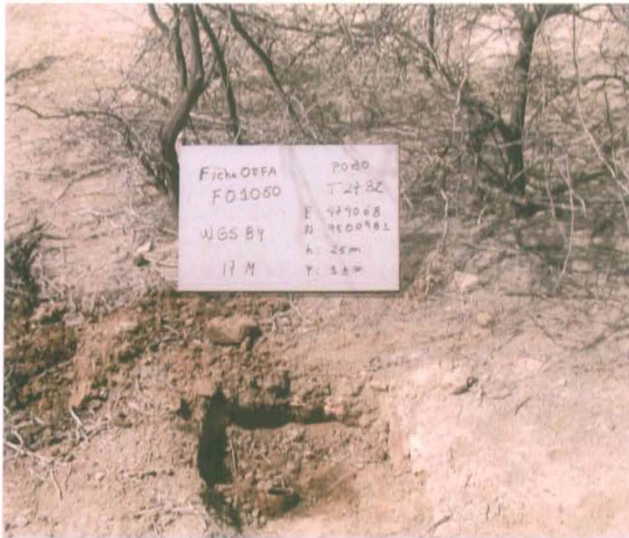
Fotografía N° 1. Pozo inactivo con código PERUPETRO T2732. Se observa casing a nivel de superficie, no presenta cabezal.
