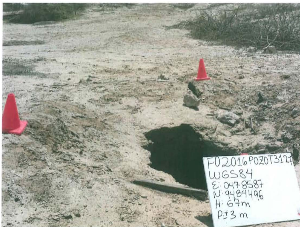
Fotografía N° 1. Pozo T3127, que se ubica dentro de un hoyo con bordes muy irregulares de 1,25 m de profundidad, el cual abarca un área de aproximadamente de 3,7 m 2 .
