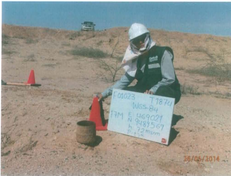
Fotografía N° 1. Pozo inactivo sin cabezal ni válvula que asegure su hermetismo, por lo que se encuentra expuesto al ambiente.
