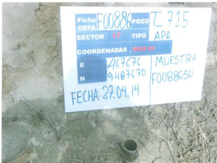
Fotografía N° 1. Vista del Pozo T_715, presenta casing abierto con fluido en su interior.
