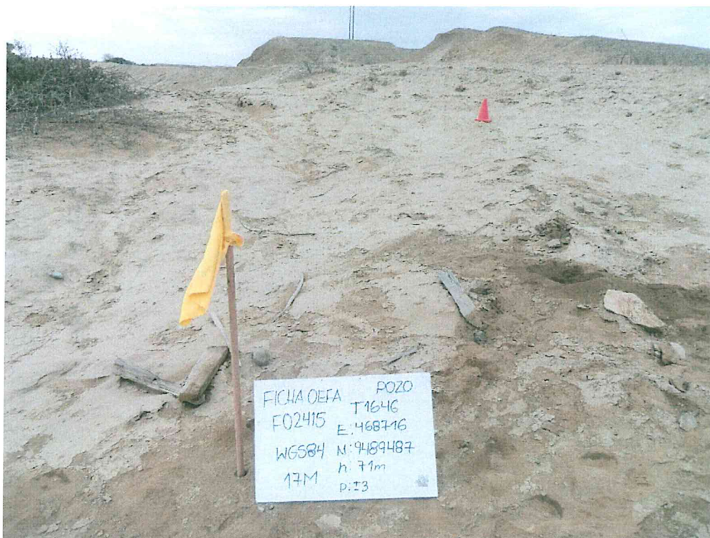
Fotografía N° 1. Pozo T1646 no ubicado superficialmente y que se encontraría enterrado, se observa suelo con hidrocarburos y restos de madera de madera en un terreno inclinado.
