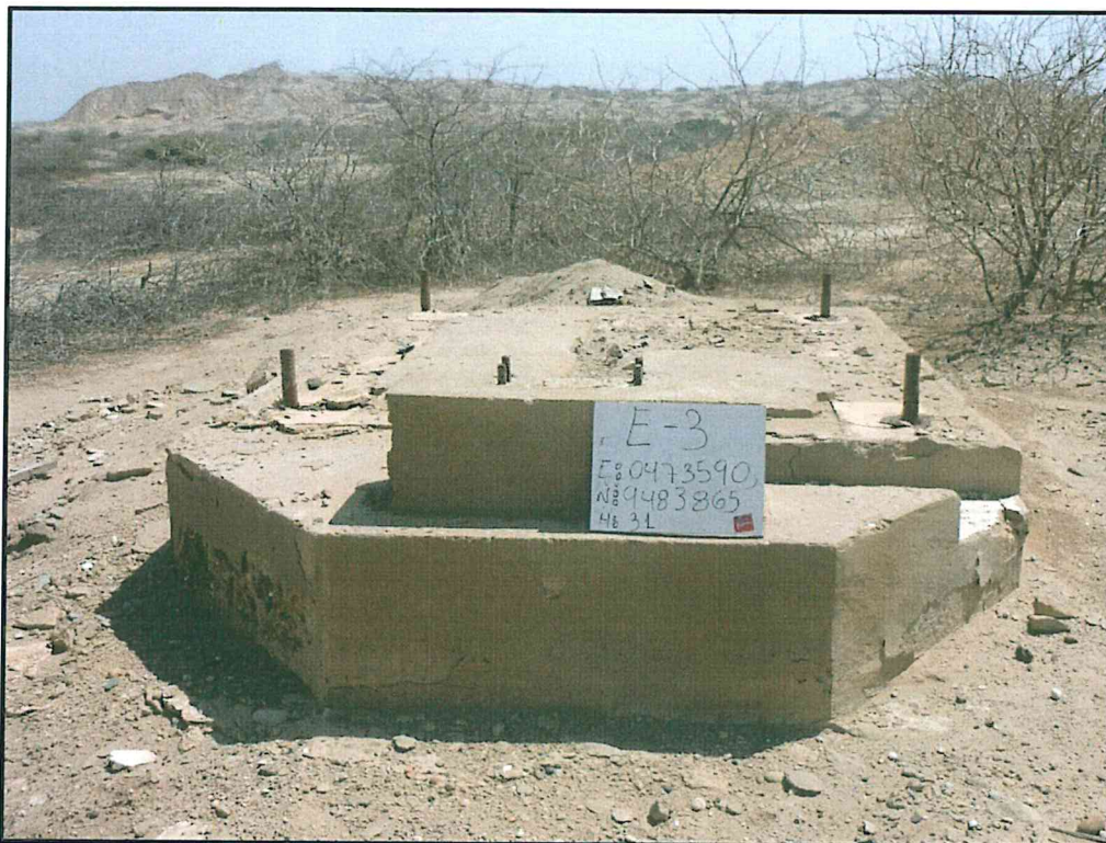
Fotografía N° 1. Vista de la instalación de producción inactiva mal abandonada, correspondiente a la ficha OEFA F00463, no se observa suelo con presencia de Hidrocarburos ni afloramiento de fluidos.
