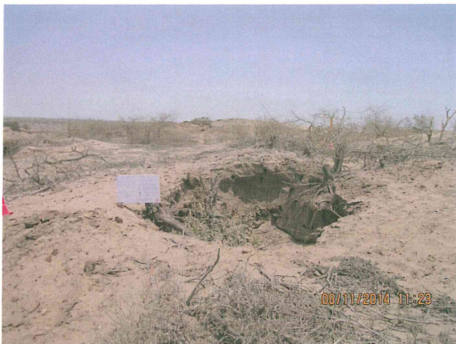
Fotografía N° 1. Se observa una excavación en la cual no se visualizó la estructura del pozo a nivel de superficie del terreno.
