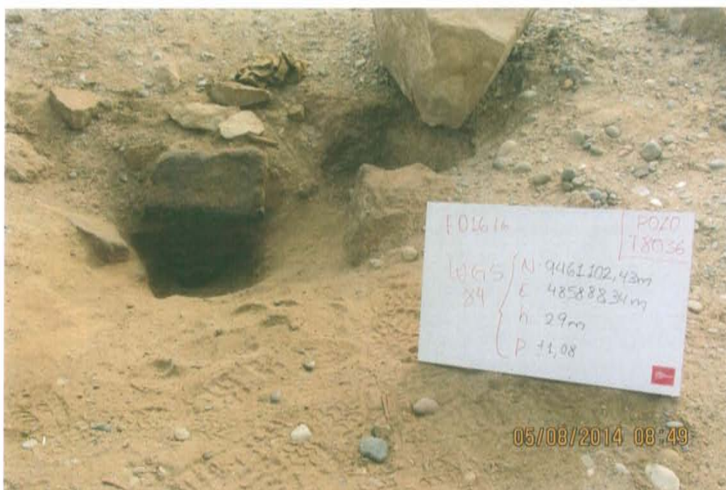
Fotografía N° 1. Se observa casing en el interior de un hoyo y emana emisiones gaseosas.
