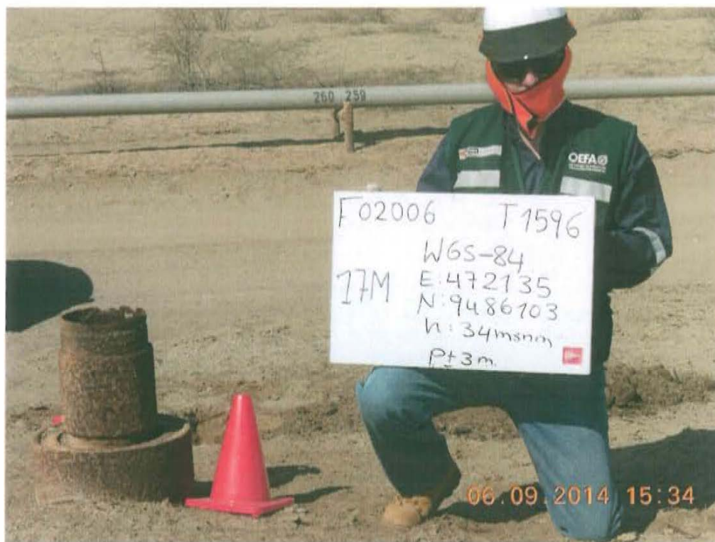
Fotografía N° 1. Identificación del pozo inactivo con código PERUPETRO T1596. Presenta dos casing corroidos sin cabezal o válvulas que aseguren su hermétismo.
