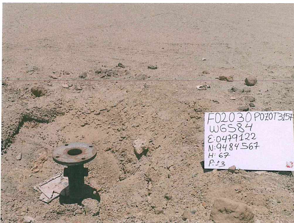
Fotografía N° 1. Pozo T3157, cuyo casing presenta brida pero no se visualizan accesorios que aseguren su hermetismo por lo que se le considera como un pozo abierto y expuesto al ambiente, el cual presenta líquido en su interior y no presenta señales ni cercos de prevención.
