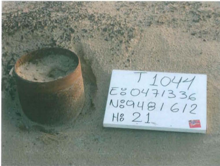
Fotografía N° 1. Pozo mal abandonado T1044 sin cabezal con casing corroído y con acumulación de tierra en su interior.
