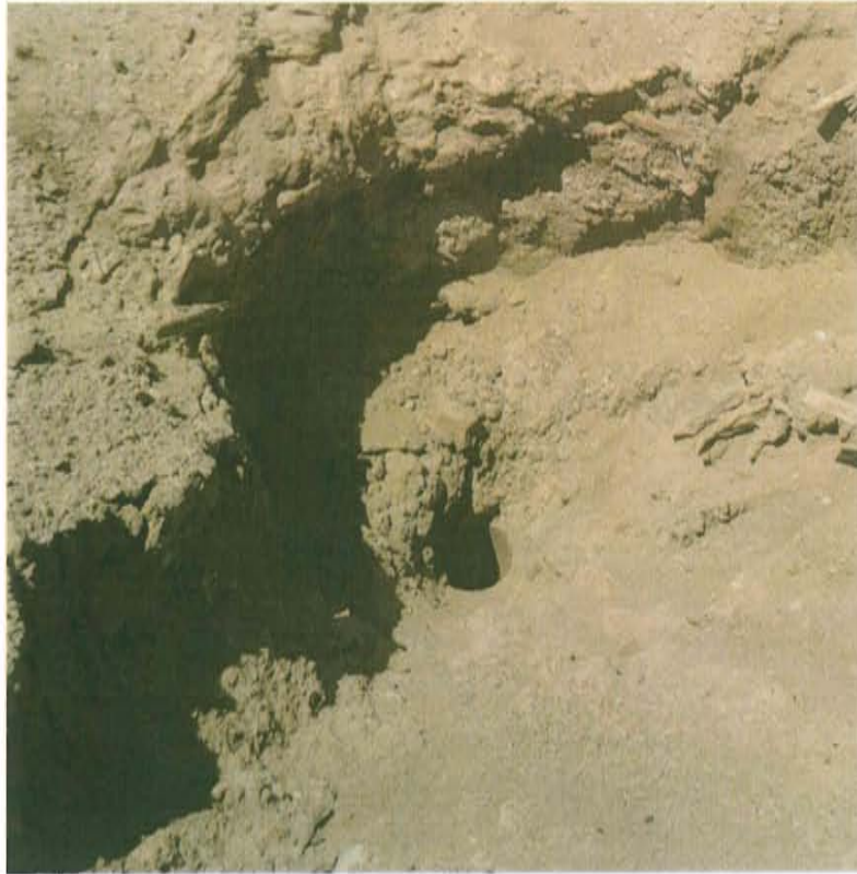
Fotografía N° 1. Ubicación del Pozo T2852 dentro de una excavación, sin cabezal ni válvulas de cierre.
