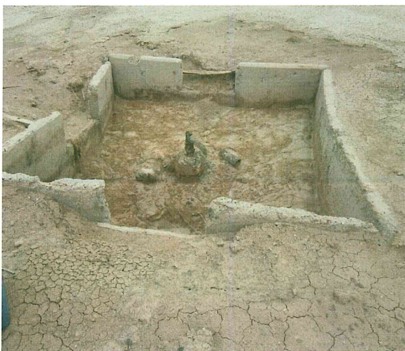
Fotografía N° 2. Se observa que el pozo inactivo se encuentra en estado de corrosión y expuesto al medio ambiente que no garantizaría el cierre hermético del pozo.
