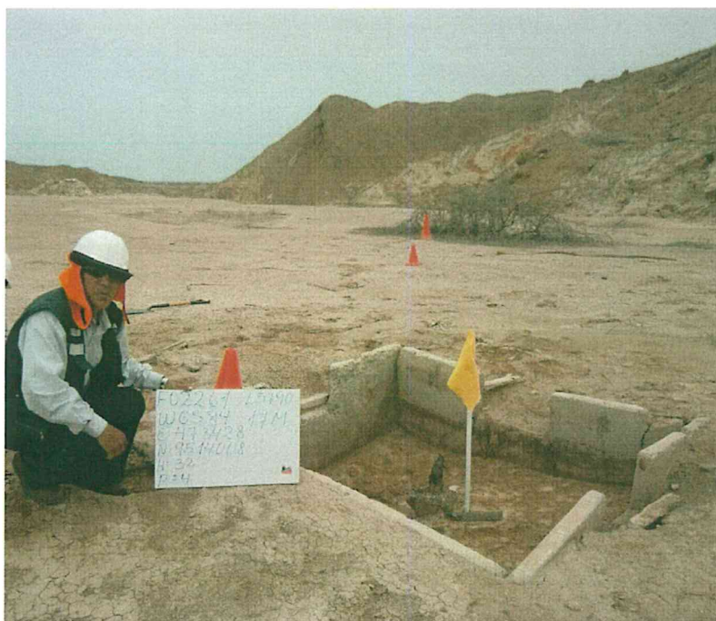
Fotografía N° 1. Ubicación del pozo inactivo en el interior de una cantina deteriorada con suelo contaminado en el área circundante.
