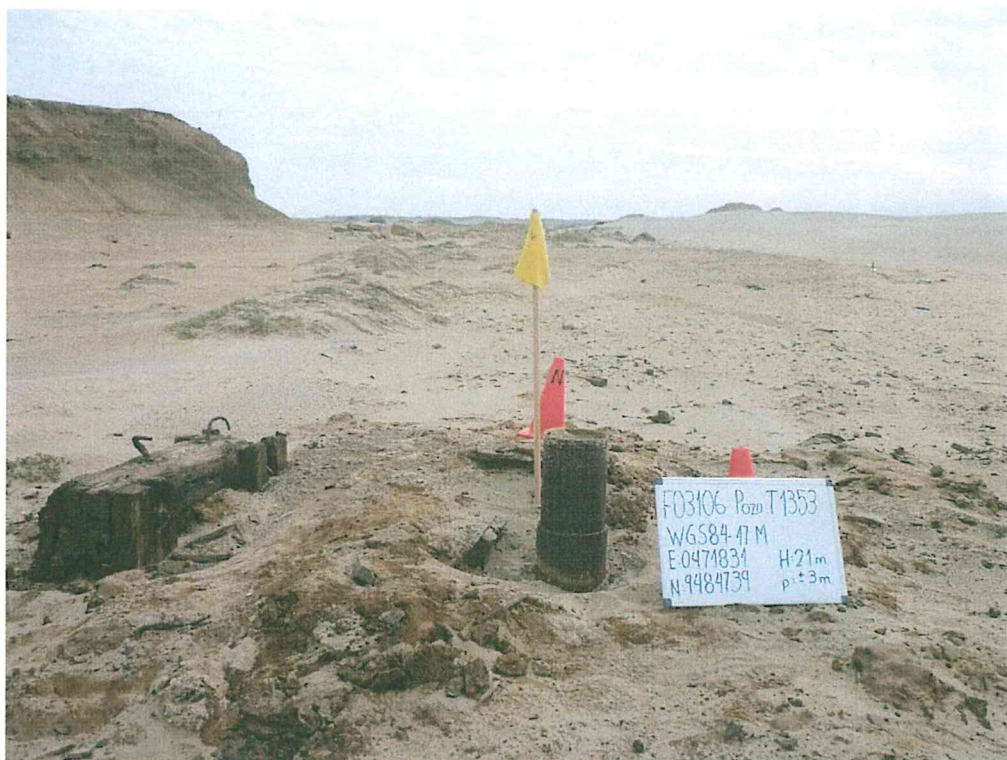
Fotografía N° 1. Vista panorámica del pozo T1353 ubicado en un montículo de suelo con presencia de hidrocarburos, se observa el casing en estado de corrosión.
