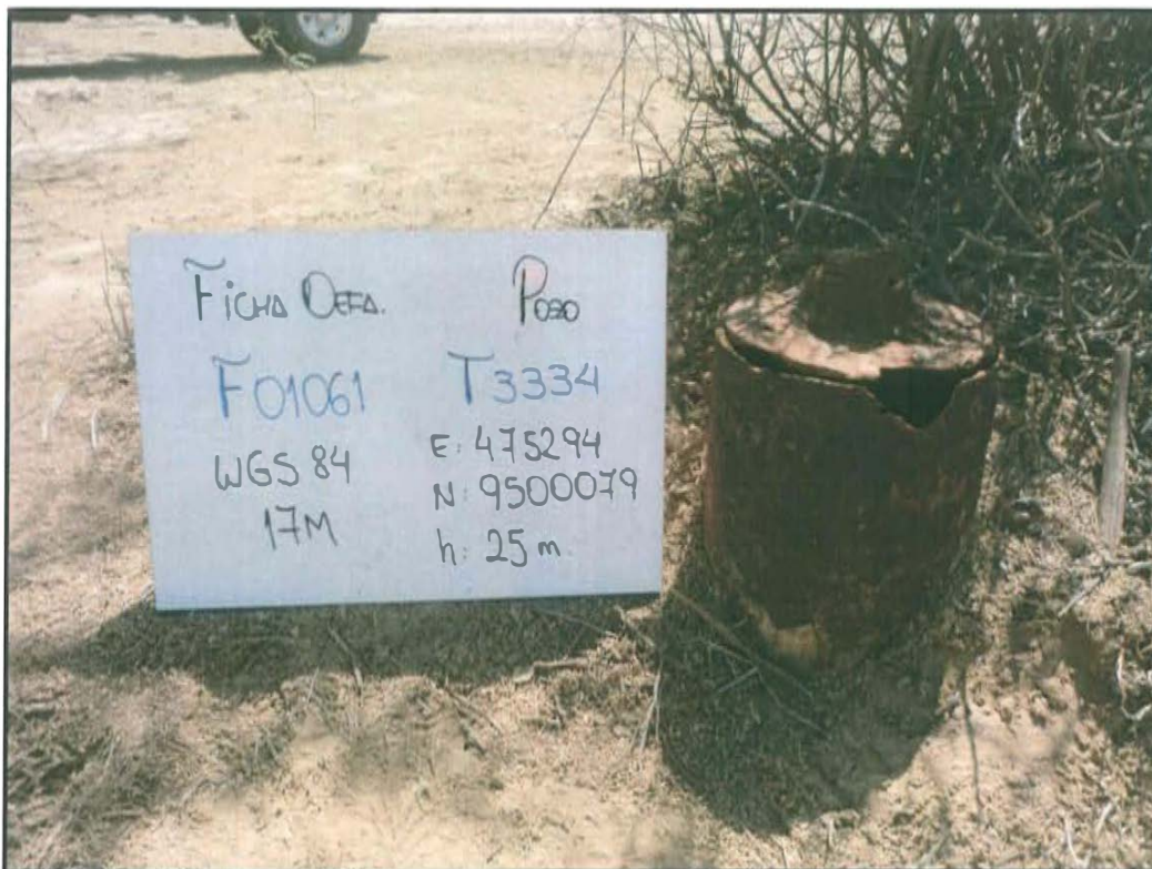
Fotografía N° 1. Pozo T3334 que cuenta con casing de 12 plg que se encuentra unido a un tubo de reducción de 6 plg, que emerge a una altura de 0,5 m desde la superficie del suelo.
