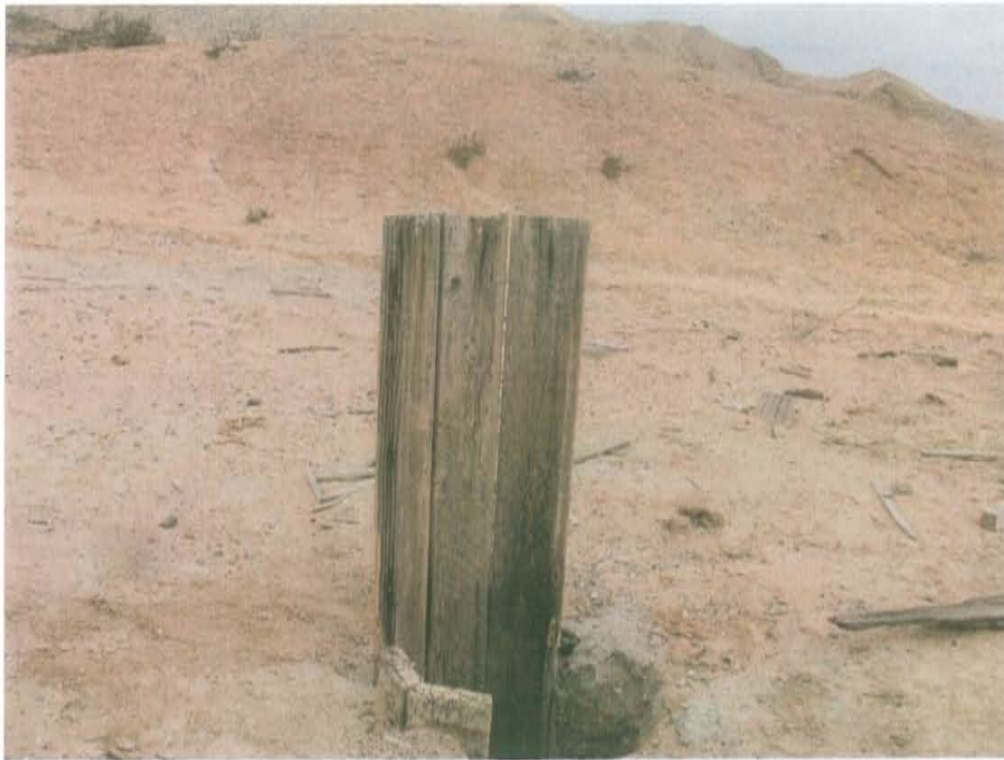
Fotografía N° 1. Pozo T_638 abierto con conductora de madera que sobresale 1 m.
