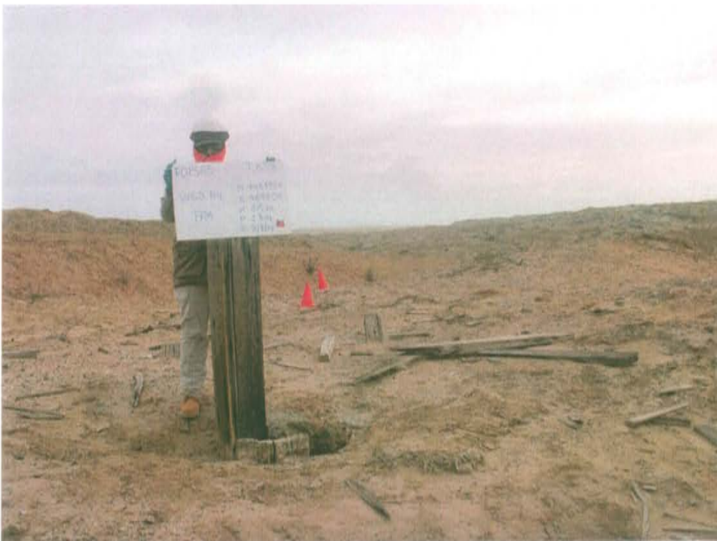
Fotografía N° 2. El pozo T_638 sin terraplén ni acceso vehicular a nivel del suelo.
