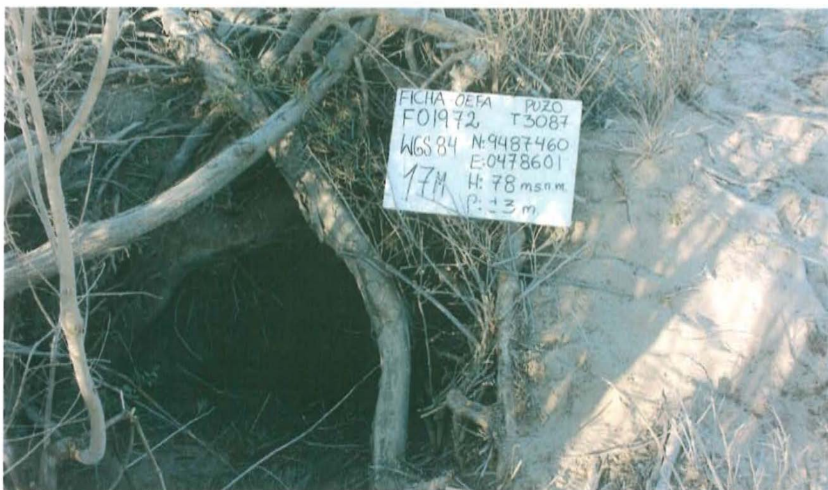
Fotografía N° 1. Pozo con código PERUPETRO T3087 y código Ficha OEFA F01972, se observa el casing dentro de un hoyo sin cabezal o algún accesorio de cierre por lo que se encuentra abierto al ambiente.
