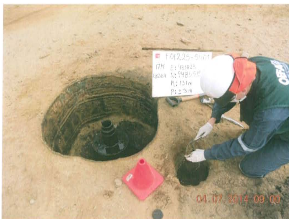
Fotografía N° 2. Se observa el pozo T2015, abierto y expuesto al ambiente, con casing con presencia de hidrocarburos líquidos en su superficie, ubicado en el interior de un cilindro metálico que cumple la función de conductora
