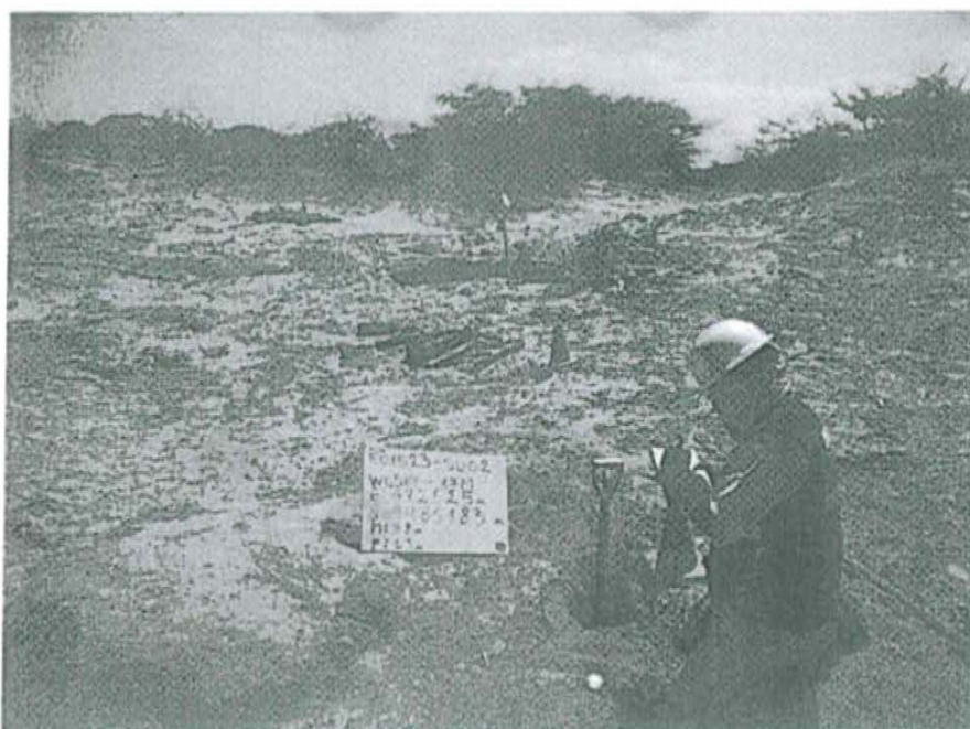
Fotografía N° 2. Toma de muestra de suelo en el punto F01523-SU02, ubicado a 9 m aproximadamente del Pozo T1694.
