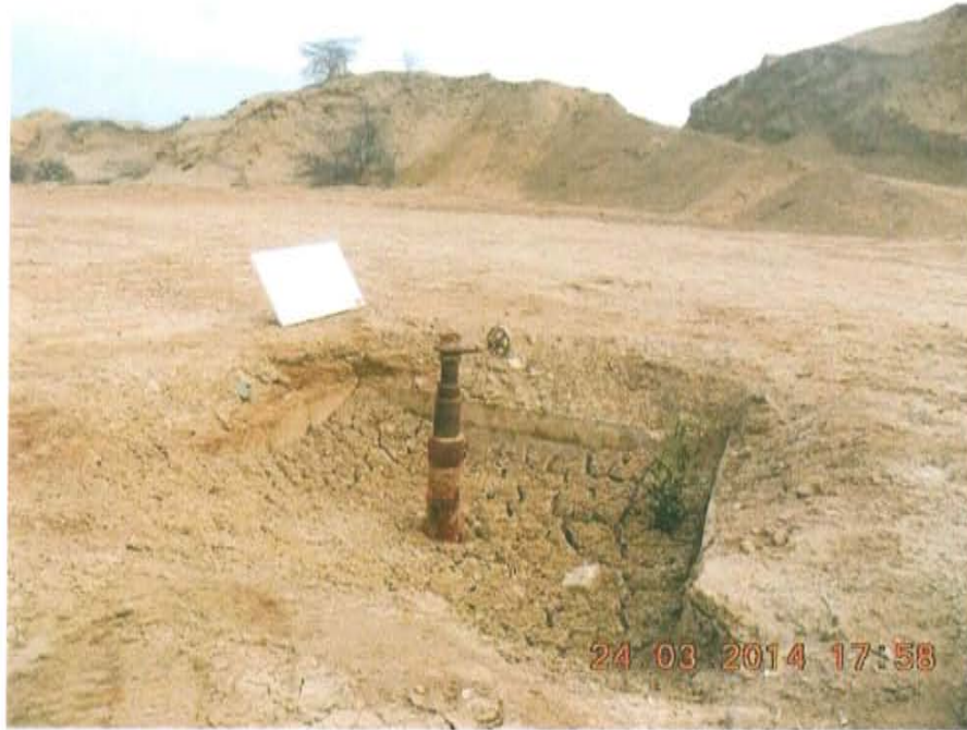
Fotografía N° 1. Vista panorámica donde se visualiza una tubería con válvula de retención, ubicada dentro de restos de una posible cantina.
