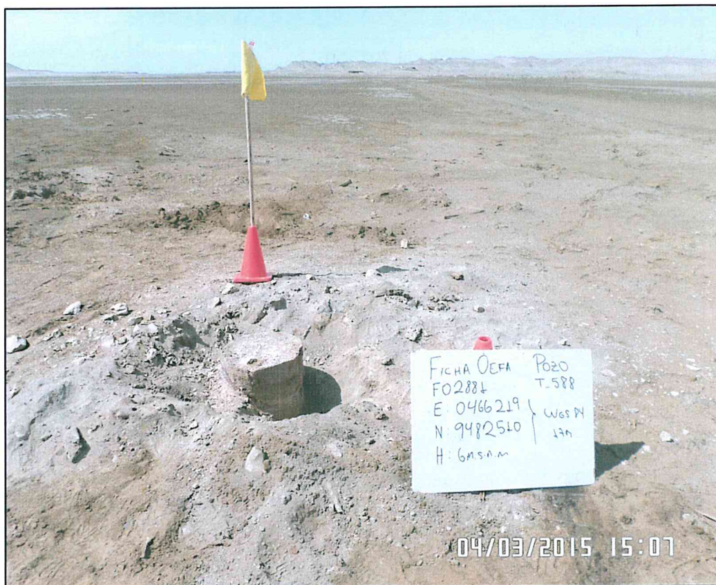
Fotografía N° 1. Casing del pozo con código PERUPETRO T_588 de 13 pulgadas de diámetro que sobresale a una altura de 0,3 m sobre la superficie del suelo.
